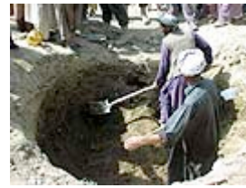
Erste Arbeiten; Ausheben der Zisterne.
